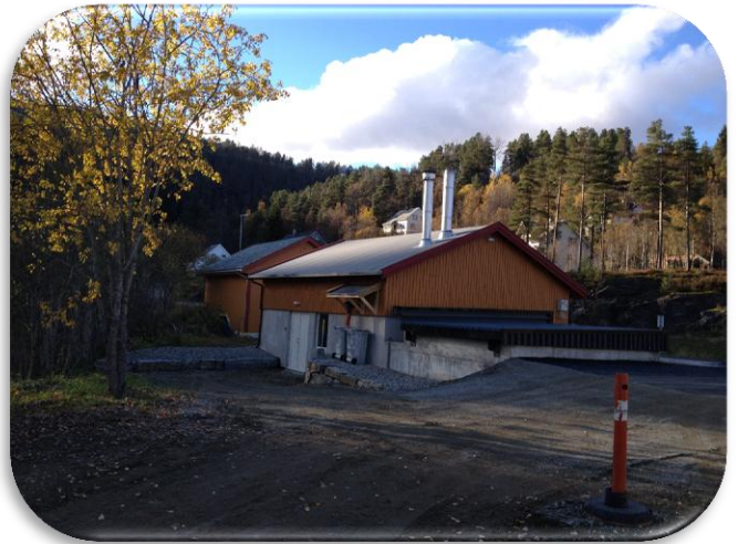
Varmesentralen på Framnes som leverer bioenergi til Vossestrand omsorgstun - Foto: Voss Energi AS
