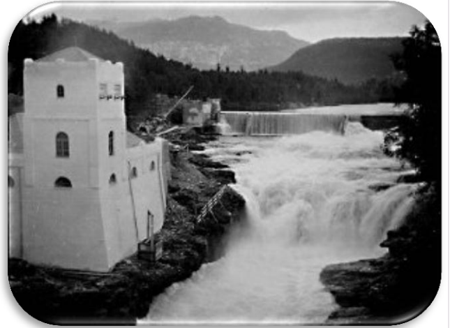
Palmafossen kraftverk – år 1919
