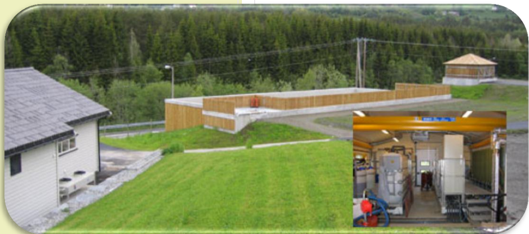
Energi- og renseanlegget på Bjørkemoen (kjelde: www.ihm.no )
